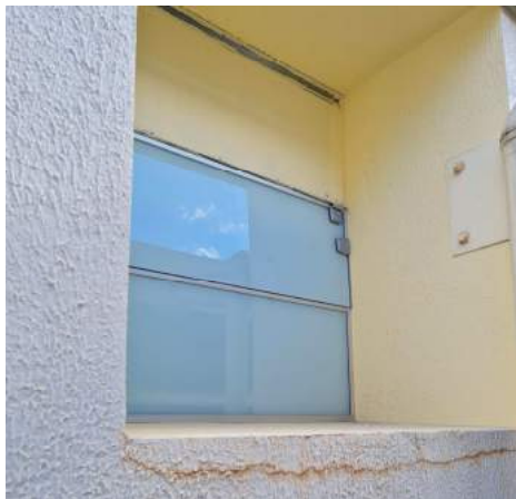
Foto Externa (caixilho padrão existente)
