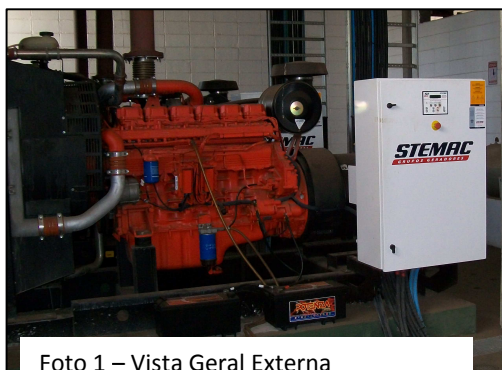
Foto 1 – Vista Geral Externa
