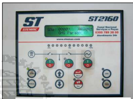
Foto 2 – Controlador Atual (vista externa)
