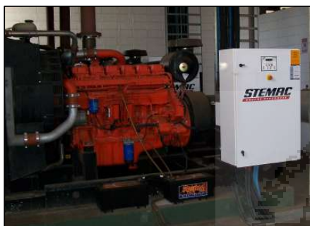
Foto 1 – Vista Geral Externa
